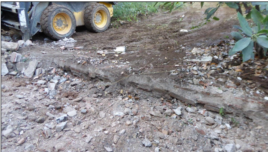
53. Detall de la pavimentació UE 150.
