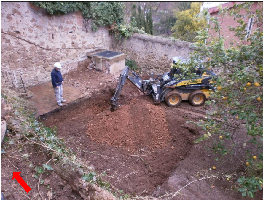
60. Imatge en perspectiva de la excavació de la cala per a col·locar la grua.
