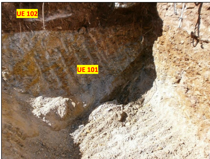
42. Detall de l'excavació del substrat geològic UE 101, per realitzar les fonamentacions de l'extrem nord.
