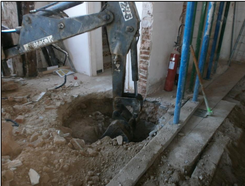
9. Detall a sud-oest de l'excavació de la Sabata 3.
