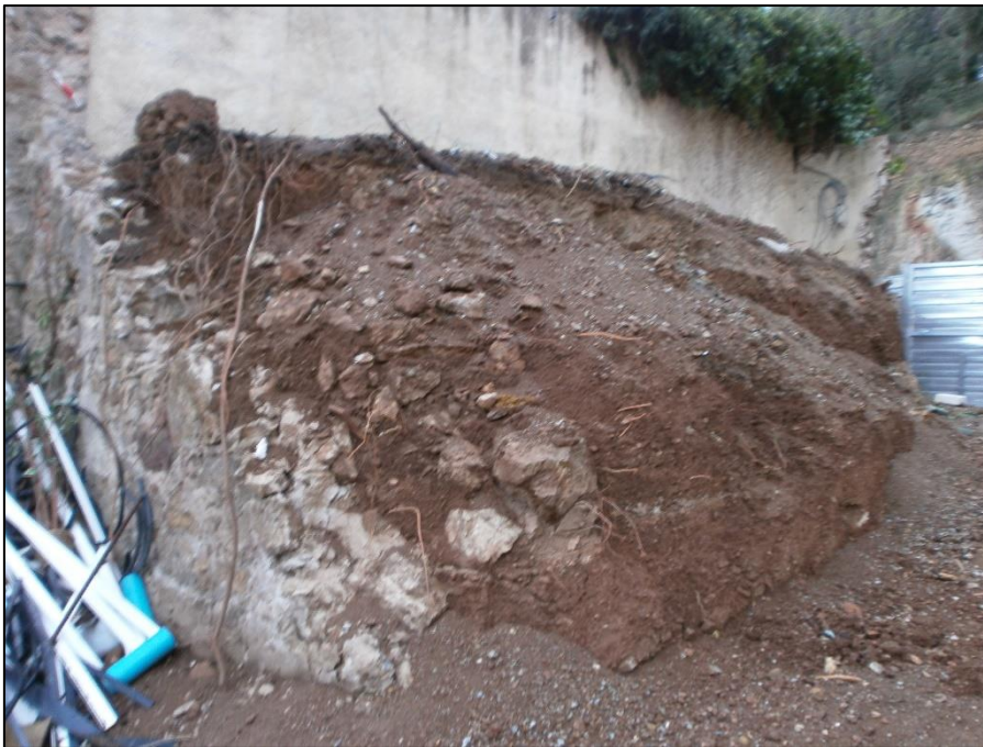
40. Detall de l'extrem sud del mur UE 134, abans del seu enderroc.
