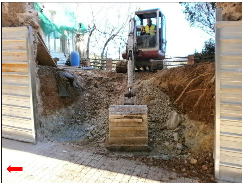
29. Inici dels treballs d'excavació del pati superior.
