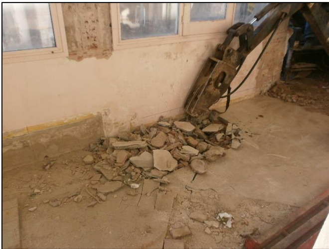
11. Inici de l'excavació de la riosta 4.
