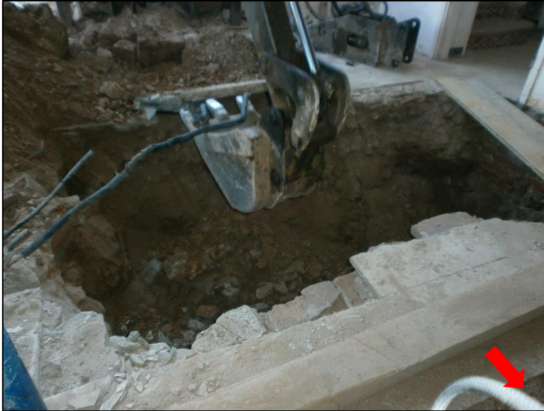
13. Procés d'excavació de la sabata 5 i la riosta 7.
