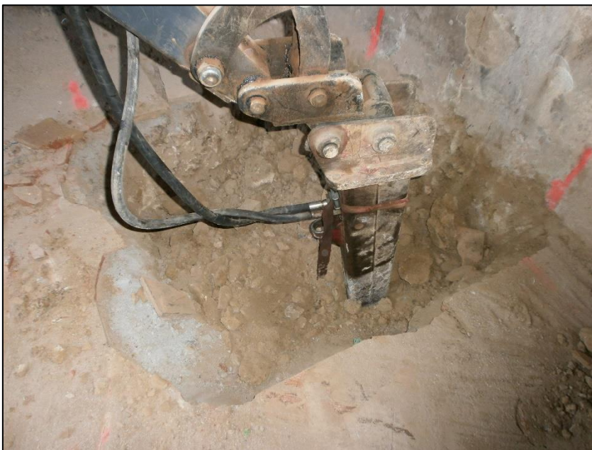
64. Imatge de la cala realitzada en la zona E, amb detall de l'excavació de la llicorella, amb un martell neumàtic, ja que aquesta aflora, després de la retirada de la pavimentació de l'habitació.
