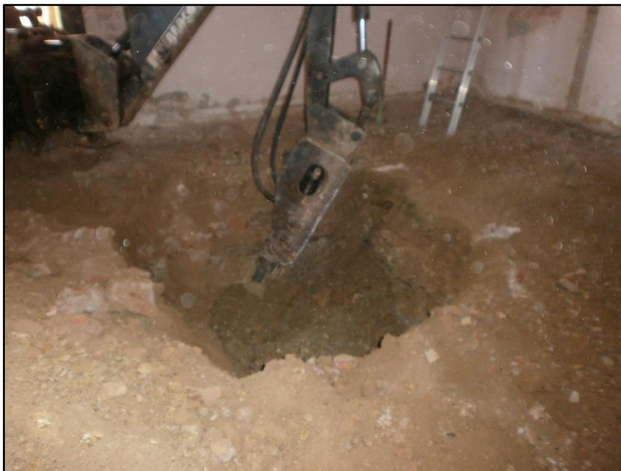
1. Imatge de detall de la excavació a màquina de la SABATA 1.
