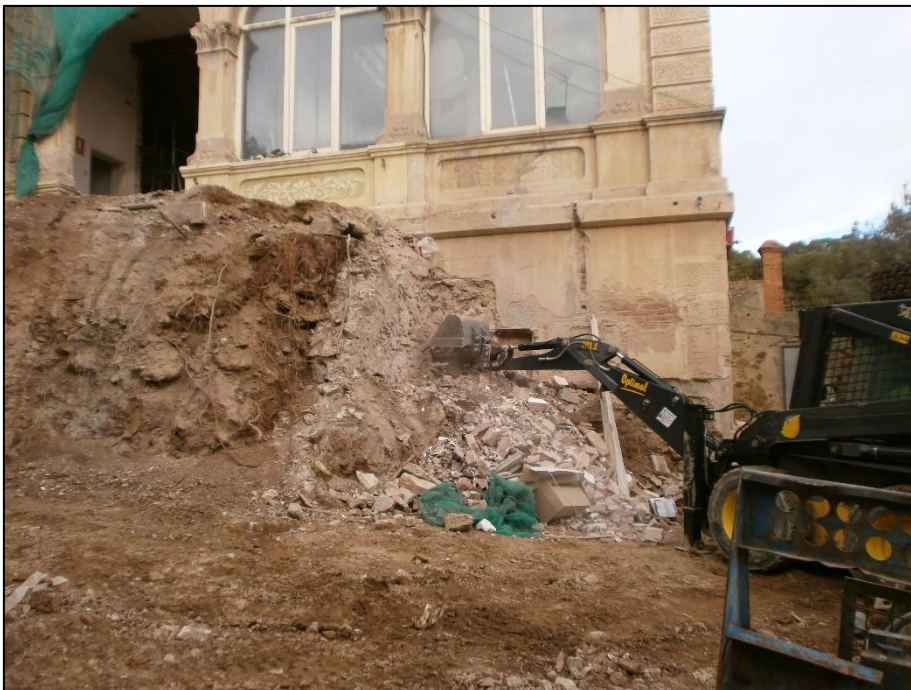
39. Moment de l'enderroc de l'extrem nord de la UE 134.
