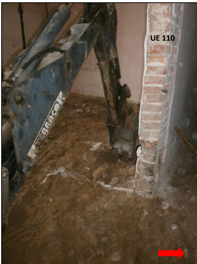
4. Inici de la excavació de la Sabata 2.
