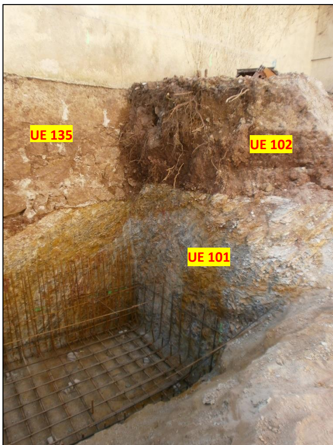
44. Imatge de la fonamentació en l'extrem sud, on s'observa el mur que separa una parcel·la d'una altra.
