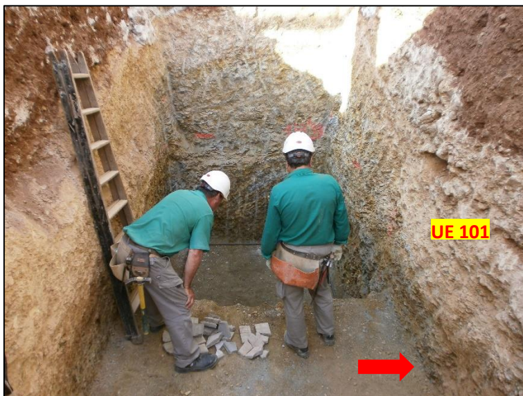
69. Detall del forat de l'ascensor, amb la llicorella rebaixada.
