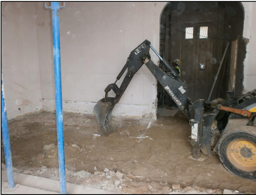
5. Detall a nord general de la excavació de la Sabata 2.
