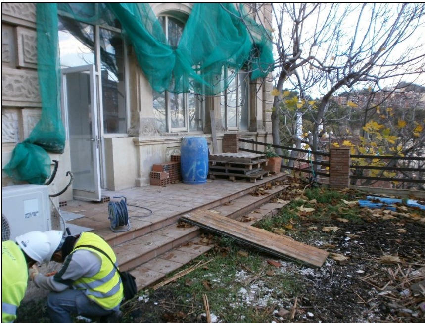
36. Estat de l'escalinata UE 133, abans del seu enderroc.
