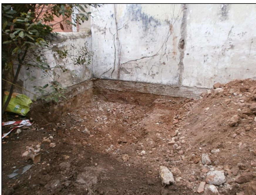
57. Detall del final de l'excavació, en l'angle sud-est de la zona D
