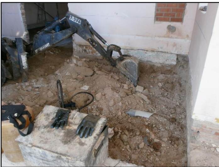
7. Detall de l'excavació general de l'interior de la planta baixa.
